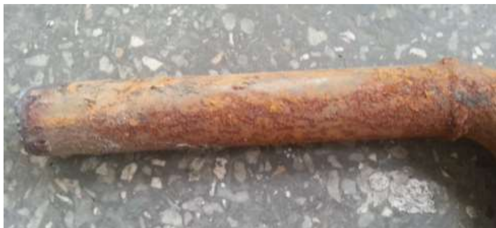
Рис. 15 – Почвенная коррозия металла
